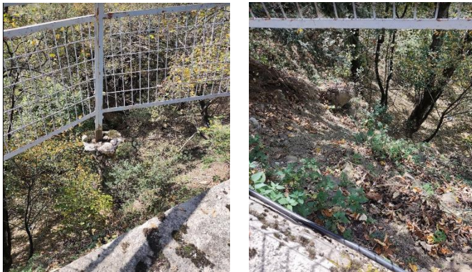
Εικόνα 10. Διάβρωση πρανού ρέματος που έχει καταστρέψει μάντρα δρόμου στο βόρειο τμήμα του οικισμού Τσεπέλοβο.
