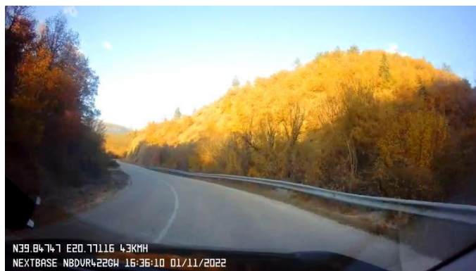
Εικόνα 54. Μετατόπιση στηθαίου ασφαλείας από το αρχικό σημείο εφαρμογής.
