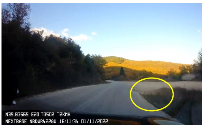
Εικόνα 43. Απουσία οριζόντιας διακεκομμένης σήμανσης στο σημείο διασταύρωσης.
