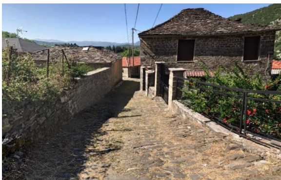
Εικόνα 61. Ποιότητα πλακόστρωτου οδικού δικτύου στο εσωτερικό του οικισμού.
