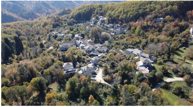
Εικόνα 15. Άποψη του οικισμού Δίλοφο μέσω Συστήματος μη Επανδρωμένου Αεροσκάφους. Πηγή: ΣμηΕΑ
