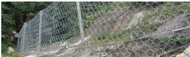
Εικόνα 79: Συστήματα συγκράτησης βράχων
