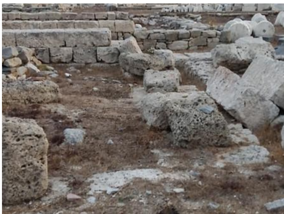
Εικόνα 62. Πώρινος Ναός. Έντονη επιφανειακή διάβρωση πωρόλιθων
