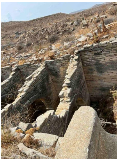
Εικόνα 48. Ανεσκαμμένη τοιχοποιία σε καλή κατάσταση μόνο με επιφανειακές φθορές
