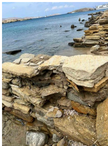
Εικόνα 44. (α) Τμήμα τοιχοποιίας σε επαφή με τη θάλασσα με μεγάλη διάβρωση και απώλεια υλικού (β) Καταρρεύσεις και διάβρωση θεμελίων σε κατασκευές δίπλα στη θάλασσα
