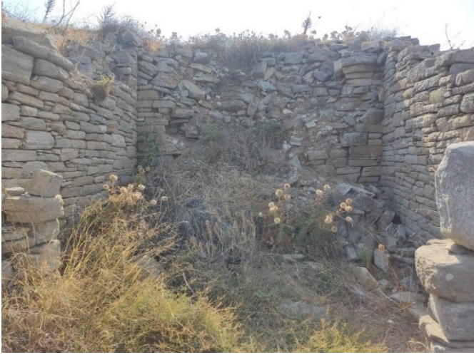
Εικόνα 71. Ανάπτυξη βλάστησης στη θεμελίωση τοιχοποιίας
