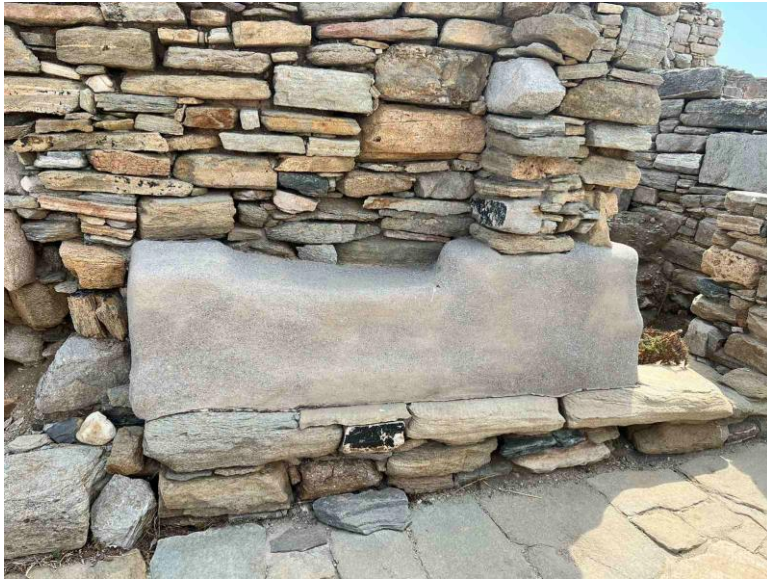
Εικόνα 75. Αποτυχημένη επέμβαση με τσιμέντο
