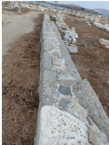
Εικόνα 69. Προστατευτικά μέτρα της τοιχοποιίας (α) Λίθοι επίστεψης (Capping) (β) Χρήση σφραγιστικού κονιάματος και πλακών
