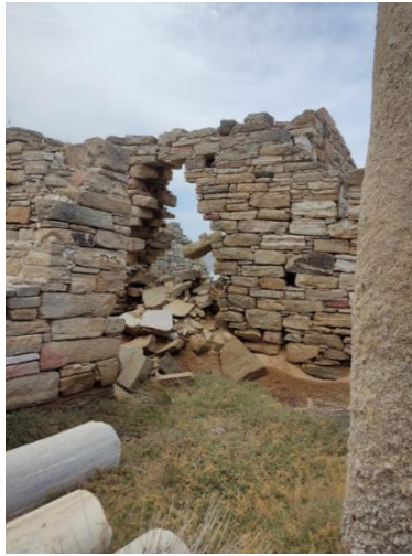
Εικόνα 43. (α) Βιολογική φθορά σε συντηρημένο δάπεδο (β) Τμήμα τοιχοποιίας που κατέρρευσε πρόσφατα λόγω αστοχίας των θεμελίων της
