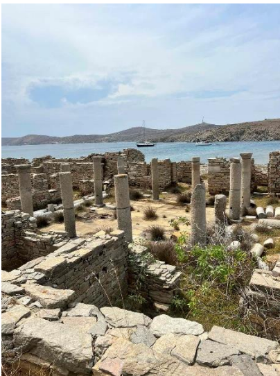
Εικόνα 72. Επικίνδυνη βλάστηση μέσα στον αρχαιολογικό χώρο
