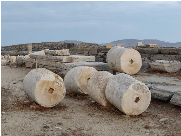
Εικόνα 60. Οίκος των Δηλίων. Οι μαρμάρινοι κίονες έχουν ελαφριά επιφανειακή διάβρωση
