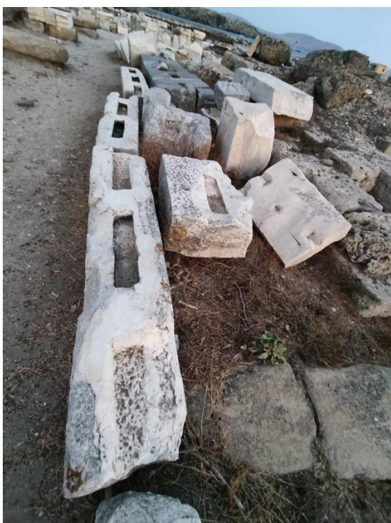
Εικόνα 63. Ναός των Δηλίων. Επιφανειακή φθορά μαρμάρου με τη μορφή θελονισμού και βιολογικές επικαθήσεις
