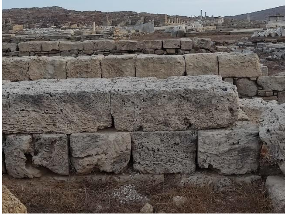
Εικόνα 34. Βελονισμός, κυψέλλωση, απώλεια υλικού και βιολογικές επικαθήσεις
