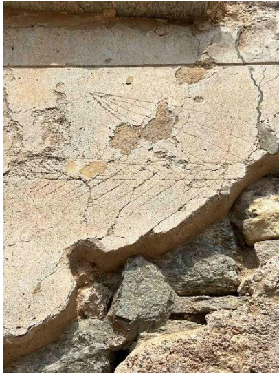
Εικόνα 68. Αρχαίο επίχρισμα με χαρακτηριστικά μεγάλο πάχος
