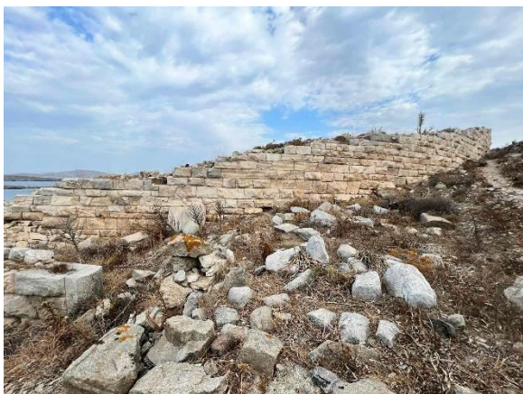
Εικόνα 48. Ανεσκαμμένη τοιχοποιία σε καλή κατάσταση μόνο με επιφανειακές φθορές
