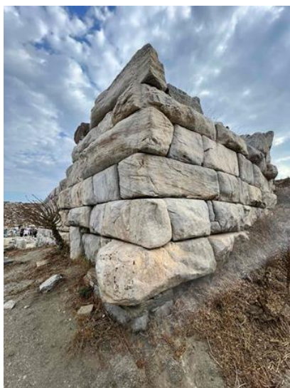
Εικόνα 48. Ανεσκαμμένη τοιχοποιία σε καλή κατάσταση μόνο με επιφανειακές φθορές
