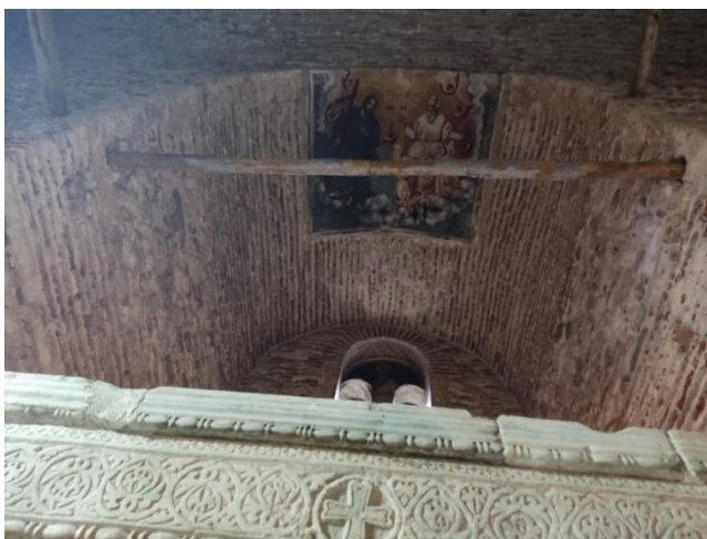
Εικόνα 49. Ξύλινος εντατήρας διαθρωμένος. Πηγή: ΕΛΛΗΝΙΚΗ ΕΤΑΙΡΕΙΑ Περιβάλλοντος και Πολιτισμού, 2024.
