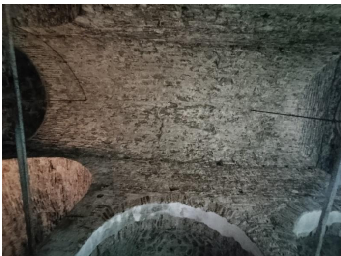
Εικόνα 37. Θόλος από επιχρισμένη αργολιθοδομή. Πηγή: ΕΛΛΗΝΙΚΗ ΕΤΑΙΡΕΙΑ Περιβάλλοντος και Πολιτισμού, 2024.
