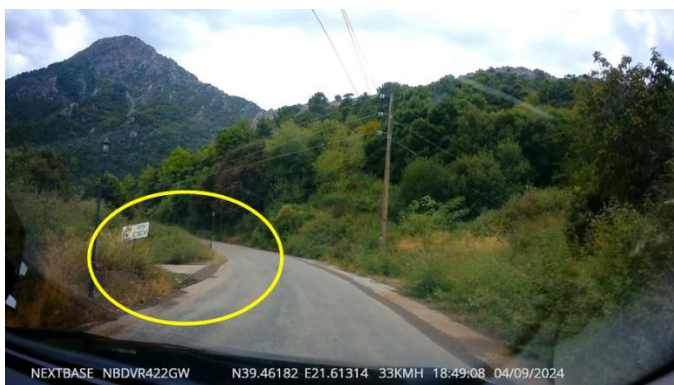
Εικόνα 68: Απουσία οριζόντιας διακεκομμένης σήμανσης στο σημείο διασταύρωσης
