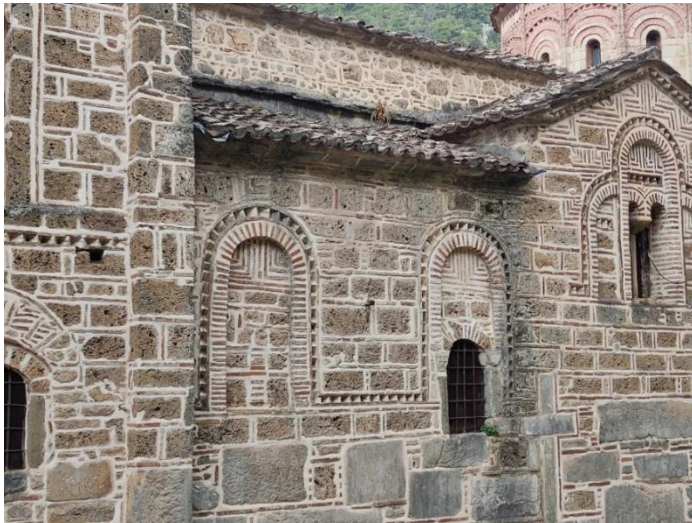
Εικόνα 35. Βόρεια όψη. Χαρακτηριστικό βυζαντινό χτίσιμο με λαξευτούς ασβεστόλιθους (σχήμα σταυρού), λαξευτούς πωρόλιθους και οπτόπλινθους. Πηγή: ΕΛΛΗΝΙΚΗ ΕΤΑΙΡΕΙΑ Περιβάλλοντος και Πολιτισμού, 2024.
