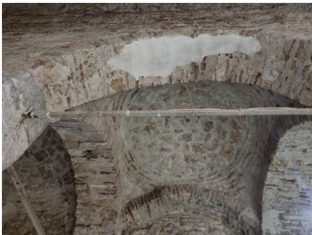
Εικόνα 43. Συντηρημένο επίχρισμα με υγρασία. Πηγή: ΕΛΛΗΝΙΚΗ ΕΤΑΙΡΕΙΑ Περιβάλλοντος και Πολιτισμού, 2024.
