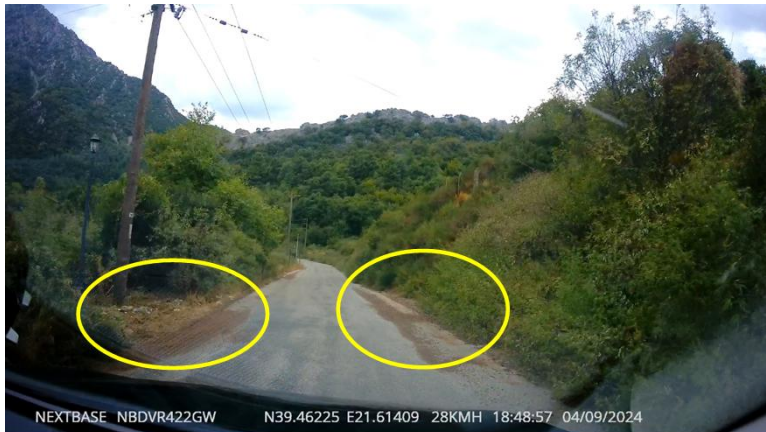
Εικόνα 62: Απουσία τάφρων απορροής ομβρίων και συγκέντρωση φερτών υλικών εκατέρωθεν της οδού
