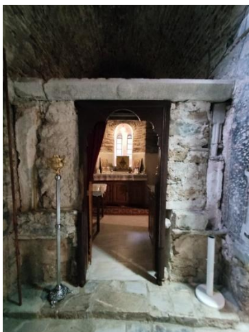
Εικόνα 92. Ρωγμή στο μαρμάρινο υπέρθυρο και στον ορθοστάτη στο εσωτερικό του Ναού που χρήζει αποκατάστασης
