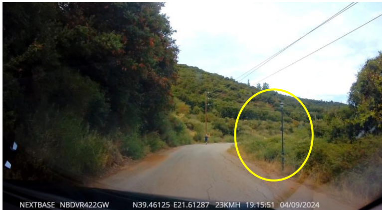
Εικόνα 63: Έλλιπής φωτισμός και απουσία ανακλαστήρων
