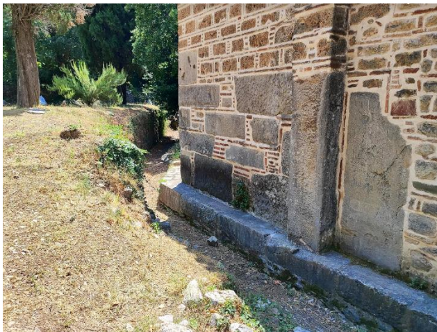
Εικόνα 12. Αποστραγγιστικό σύστημα πέριξ του Ναού Πόρτα Παναγιά.
