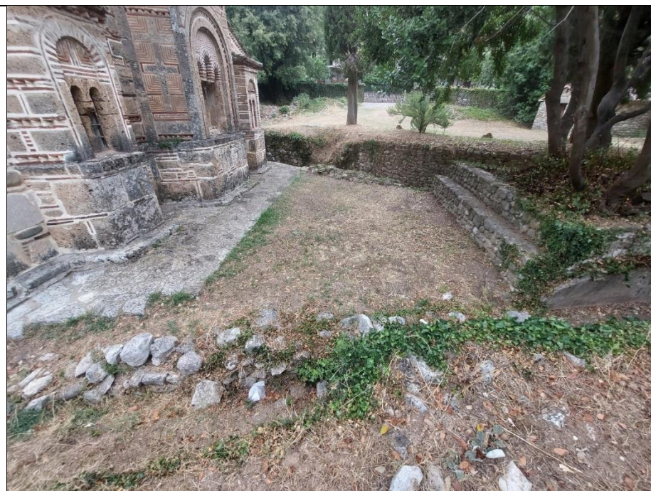
Εικ.11 Πόρτα-Παναγιά. Περιβάλλον χώρος. Αποστραγγιστική τάφος στα Α του ναού (Σ. Μαμαλούκος Αύγουστος 2024)
