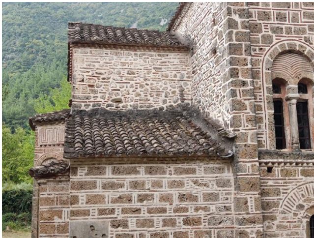
Εικόνα 39. Βιολογική φθορά και επικαθήσεις στα κεραμίδια. Πηγή: ΕΛΛΗΝΙΚΗ ΕΤΑΙΡΕΙΑ Περιβάλλοντος και Πολιτισμού, 2024
