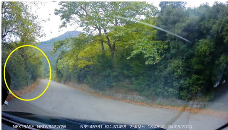
Εικόνα 64: Έλλιπής φωτισμός και απουσία ανακλαστήρων
