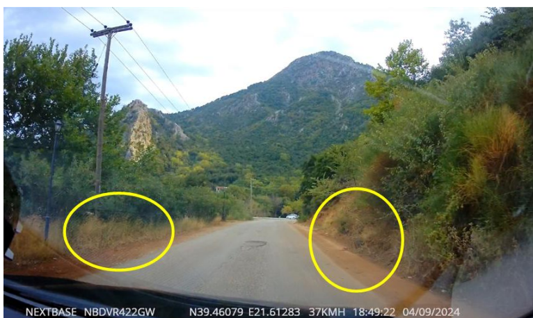
Εικόνα 61: Απουσία τάφρων απορροής ομβρίων
