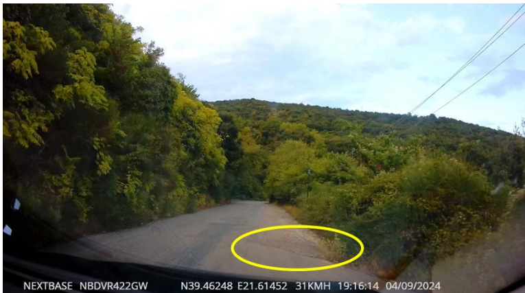
Εικόνα 57: Περίπτωση κακής συντήρησης οδοστρώματος και απουσία οριζόντιας σήμανσης
