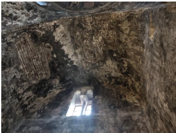
Εικόνα 86. Βιολογικές επικαθήσεις στα ιστορικά επιχρίσματα που χρειάζονται καθαρισμό
